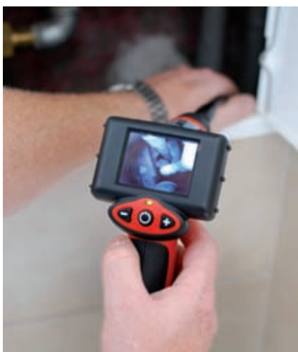
Endoskopie in einem Leitungsschacht
